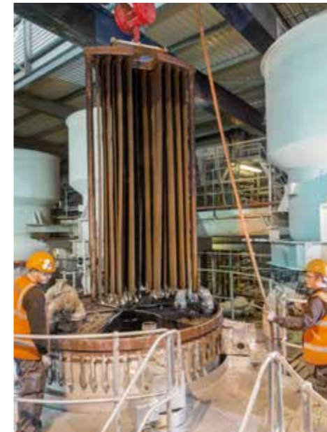
Fast, safe and easy replacement of the patented, pie-shaped filter segments. Remplacement rapide, sûr et facile des segments de filtre brevetés en forme de camembert. La sustitución rápida, segura y fácil de los segmentos de filtro patentados en forma de cuña.
