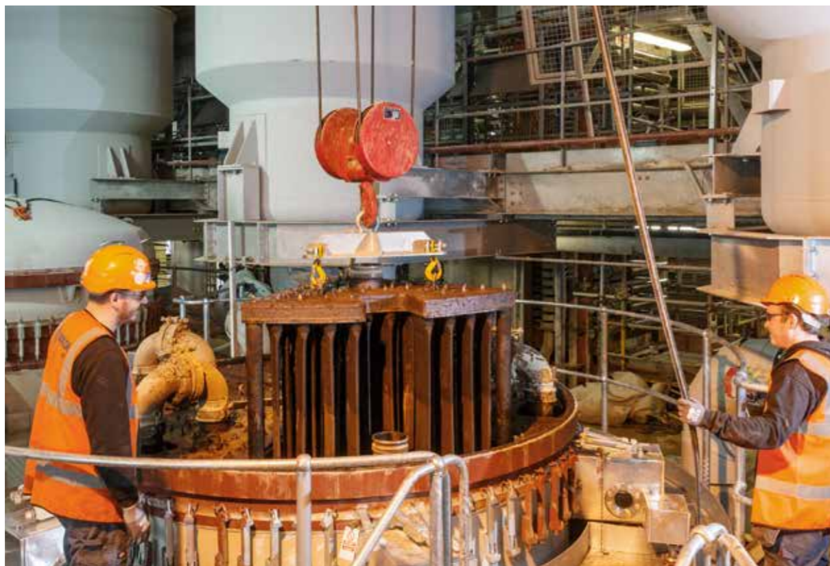
The filter vessel hold the filter segments with the mounted filter elements. Les cuves de filtre contiennent les segments de filtre équipés des éléments filtrants. Los depósitos contienen los segmentos del filtro con los filtros montados.
